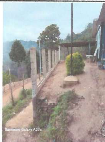
Foto 2: MEJORAMIENTO DE ESTRUCTURA DE CERCO O MURO PERIMETRAL
