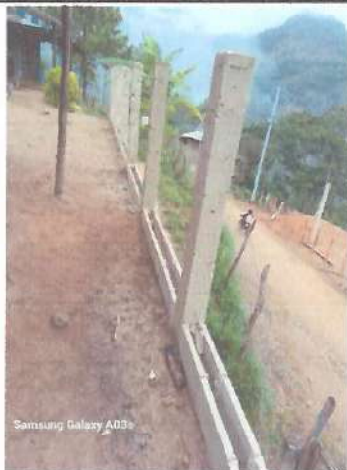
Foto 1: MEJORAMIENTO DE ESTRUCTURA DE CERCO O MURO PERIMETRAL
